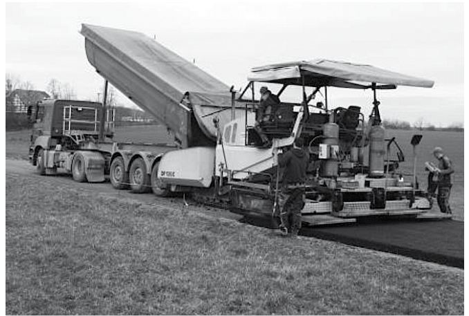
Nach der Zementstabilisierung des Unterbaus wurde die bituminöse Tragschicht aufgebracht.
