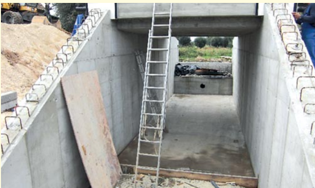
Ersatzneubau Brücke über den Kleinen Gerstenbach
