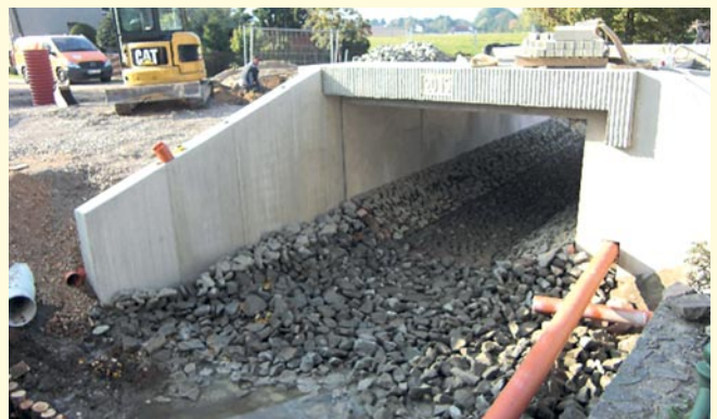
Neubau Brücke über den „Kleinen Jordan“
