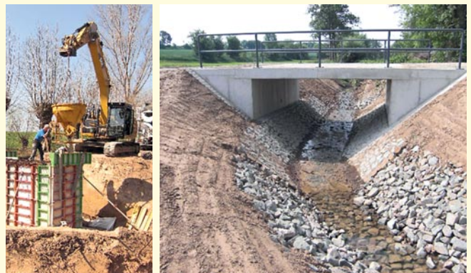
Neubau Brücke „In der Wind“ (bereits fertiggestellt)
