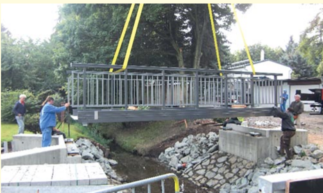
Neue Fußgängerbrücke an der Turnhalle
