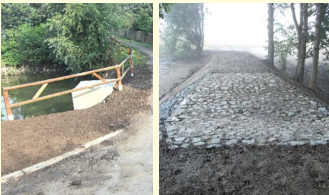
Erneuerung Teichauslaufbauwerke Teich II und Teich IV (bereits fertiggestellt)
