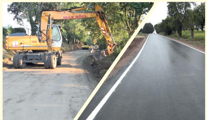
Ausbau Gemeindestraße (bereits fertiggestellt)
