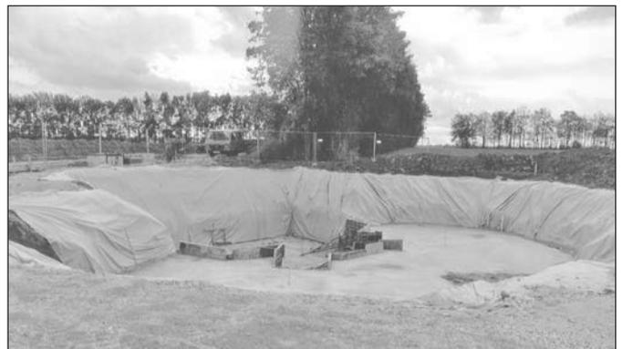
Betonplatte für Technikraum und Hochbehälter gegossen
