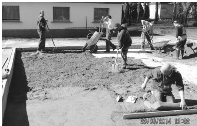
Fördervereinsmitglied Andy Franke und Mitarbeiter seiner Firma sowie weitere Vereinsmitglieder und Kommunalarbeiter beim Einbringen von neuem Beton.
