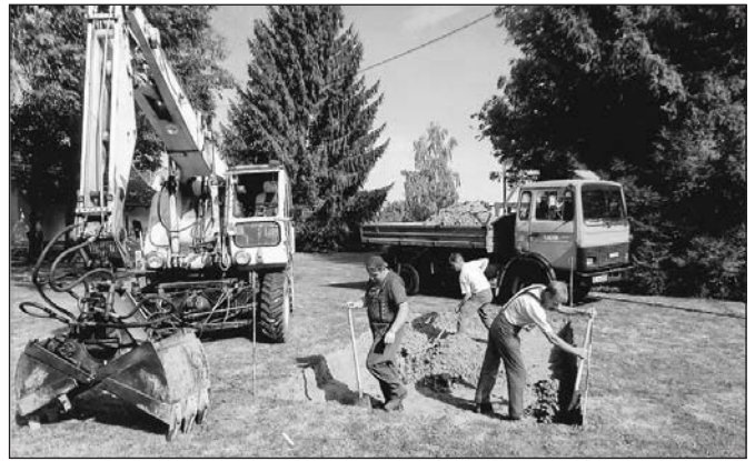
Kommunalarbeiter bei Vorbereitungsarbeiten zum Aufstellen der Tischtennisplatte.
