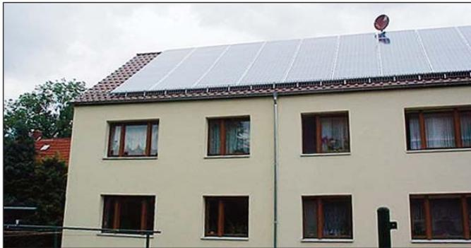
Arbeiten waren schon sehr lange geplant und mussten 2011 wegen dringender Erneuerung der maroden Kläranlage zunächst verschoben werden. Neben dem neuen Dach, der Außendämmung mit neuem Putz, bekam der Wohnblock, genau wie unser Gemeindehaus, sein eigenes kleines Kraftwerk auf das Dach. Die Thüringer KomSolar Stiftung ließ diese Fotovoltaikanlage errichten.
