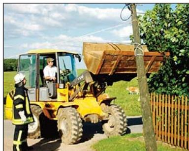
Durch die Feuerwehr wurde das Kabel umverlegt, somit konnte die Telefonverbindung im Ort weiterhin gewährleistet werden. Der Mast war so morsch, dass er keinerlei Standfestigkeit mehr bot u. aus Sicherheitsgründen gefällt wurde.
