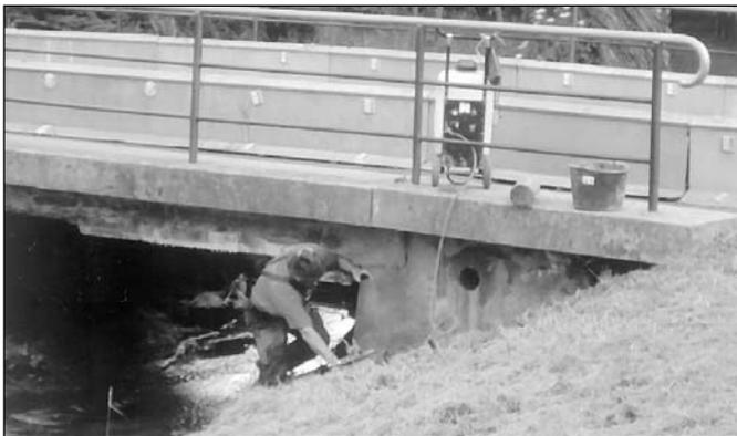
Mit den Kernbohrungen am Brückenbauwerk Gimmeler Weg in Altkirchen haben die Vorbereitungen zur Sanierung der Brücke begonnen.
