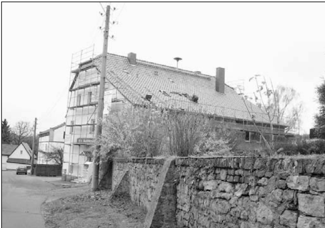
Dachhälfte „Am Rittergut“
