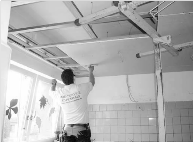
Umbau der Küche in der Kita
